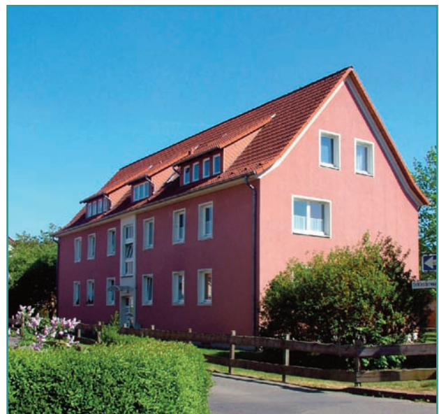
Objekt: Schlesierweg in Gimte
