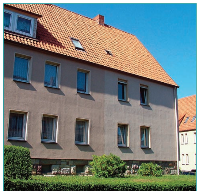
Objekt: Am Sportplatz 1-3
